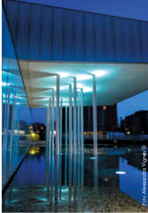
Particolare dei pilastri di sostegno della soletta a sbalzo dell'Auditorium
