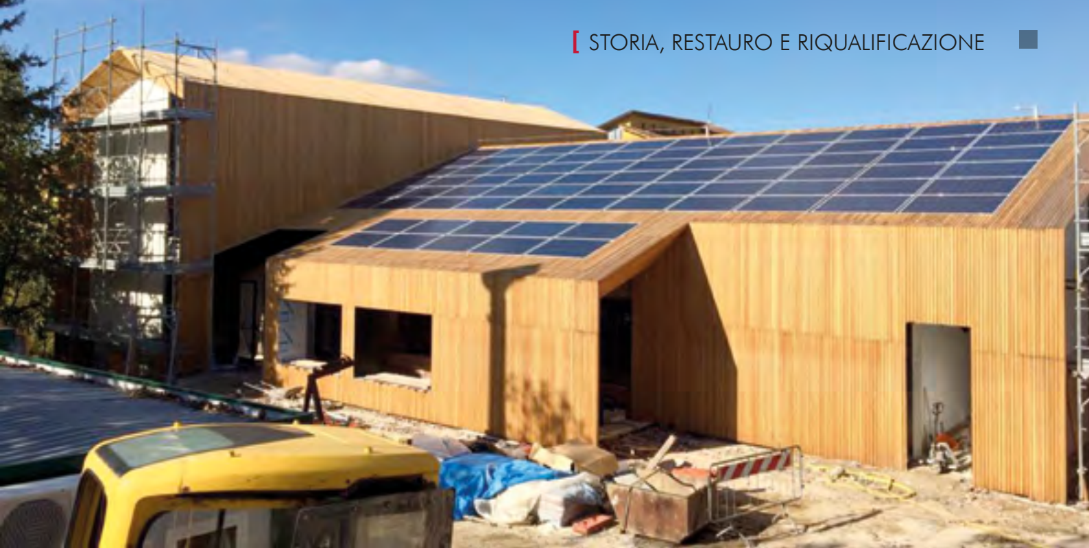
9. Ristrutturazione della Casa della Cultura, Aquilonia (AV)
