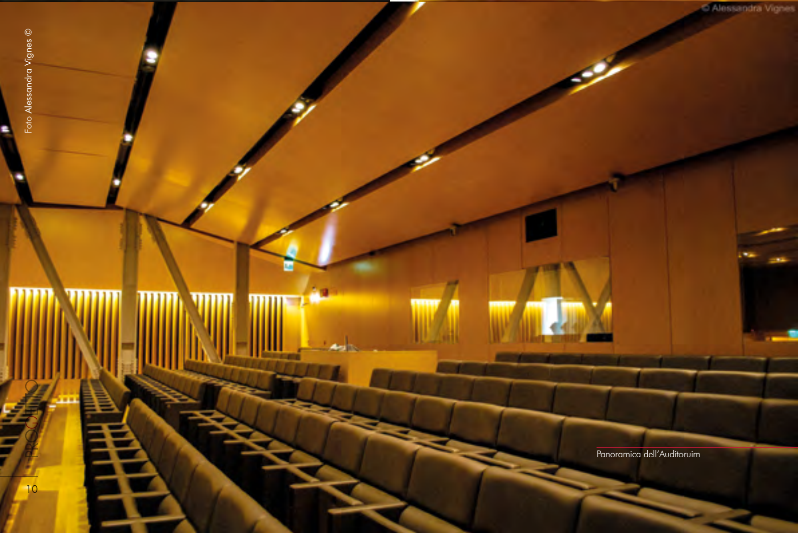
Particolare dei pannelli laterali dell'auditorium con acustica studiata in modo da essere modulabile a seconda dell'evento ospitato
